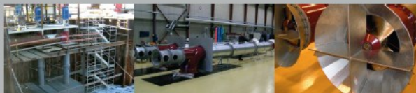
Dokpumper til skibsværft, tørdok installation.
